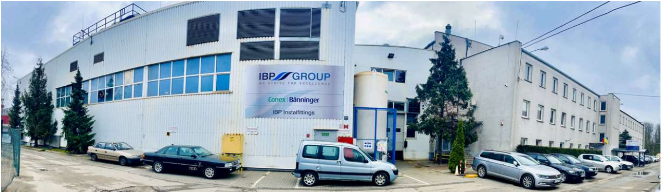
Fig. 1. IBP Instal fittings plant at Stanisława Zwierzchowskiego Street 29 in Poznań (Poland)
